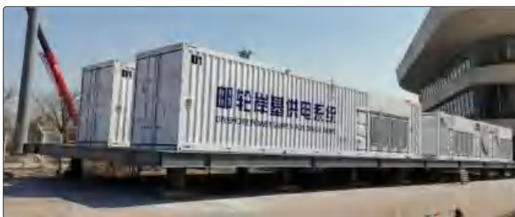
邮轮船舶岸基供电系统
